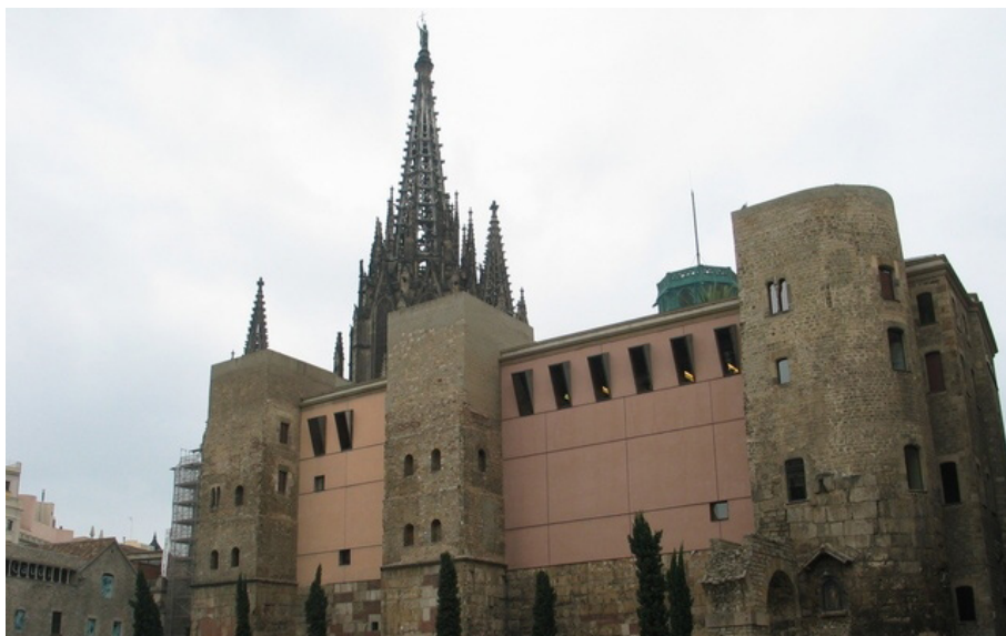
FOTOGRAFIA 39. Casa de l'Ardiaca (muralla romana, nou contenidor 1996), Barcelona
