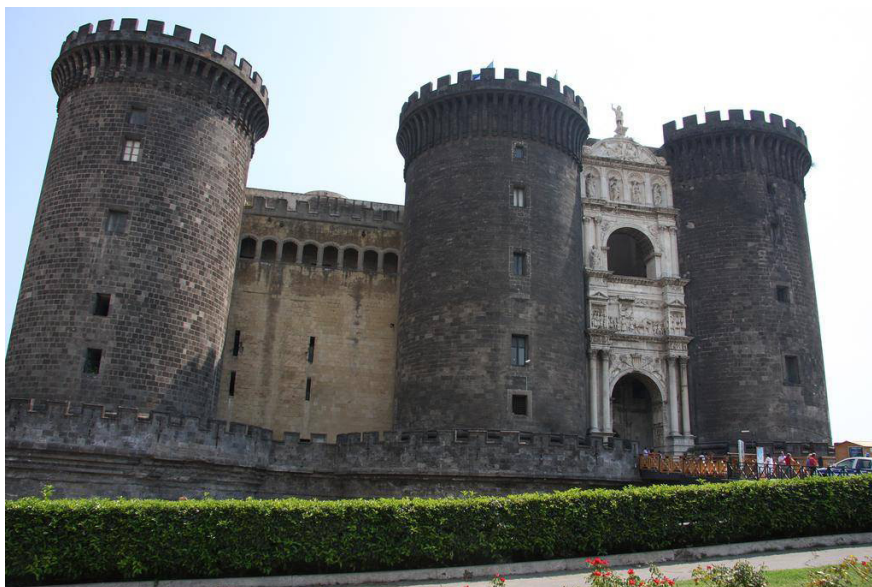
FOTOGRAFIA 6. Arc de triomf d'Alfons el Magnànim (1452-1471), Castell Nou, Nàpols
