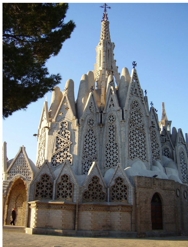
FOTOGRAFIA 37. Basílica de la Mare de Déu de Montserrat (Josep Maria Jujol, 1926-1935), Montferri
