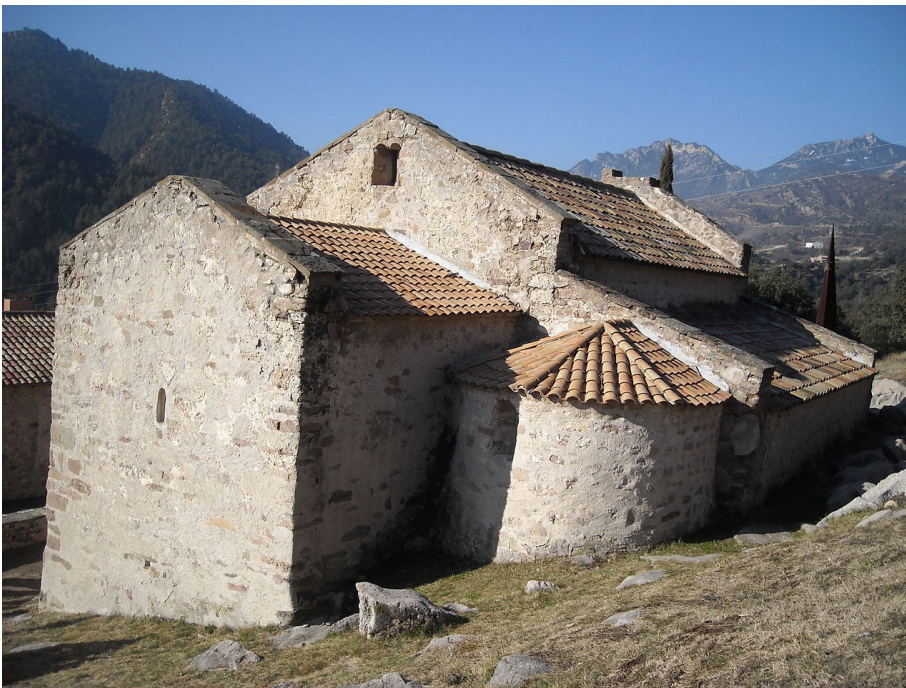
FOTOGRAFIA 26. Sant Quirze de Pedret (preromànic; restauració d'Antoni González Moreno-Navarro)
